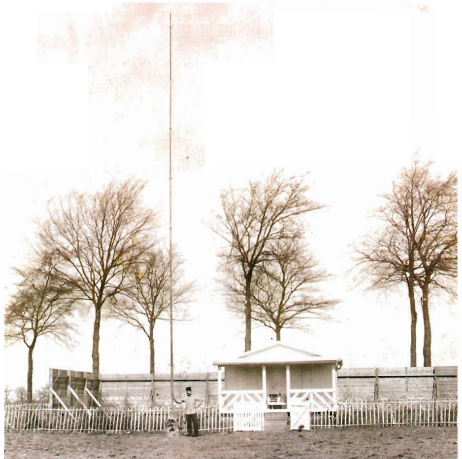
Villacoublay 1911, on distingue ici la station de réception avec son antenne verticale, la réception se fait sur un récepteur à détecteur électrolytique.
