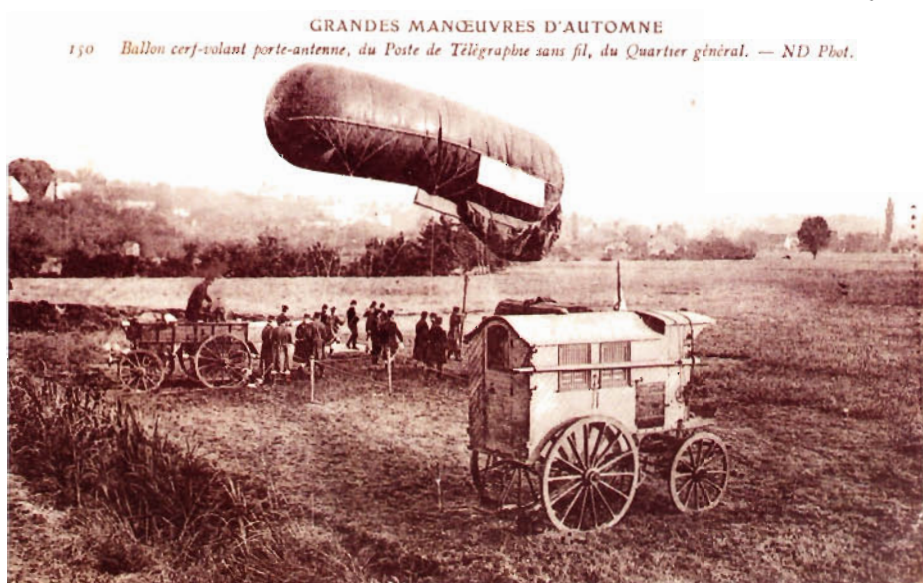
Première station TSF mobile hippomobile, cette station sera accrochée au Grand quartier général. L'antenne est tirée par un dracken . Les grandes places de l'Est seront équipées d'un matériel similaire. Collection A. Salles.
