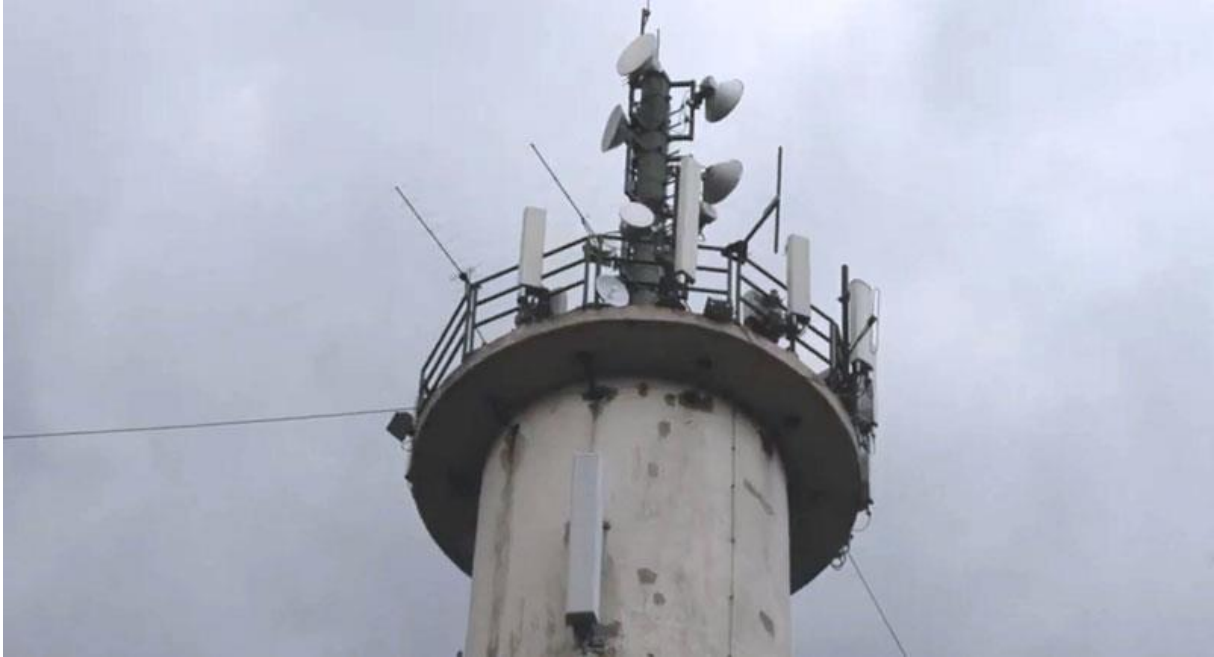
La tour en béton pour Vodafone et les antennes FM (capture de la vidéo)
