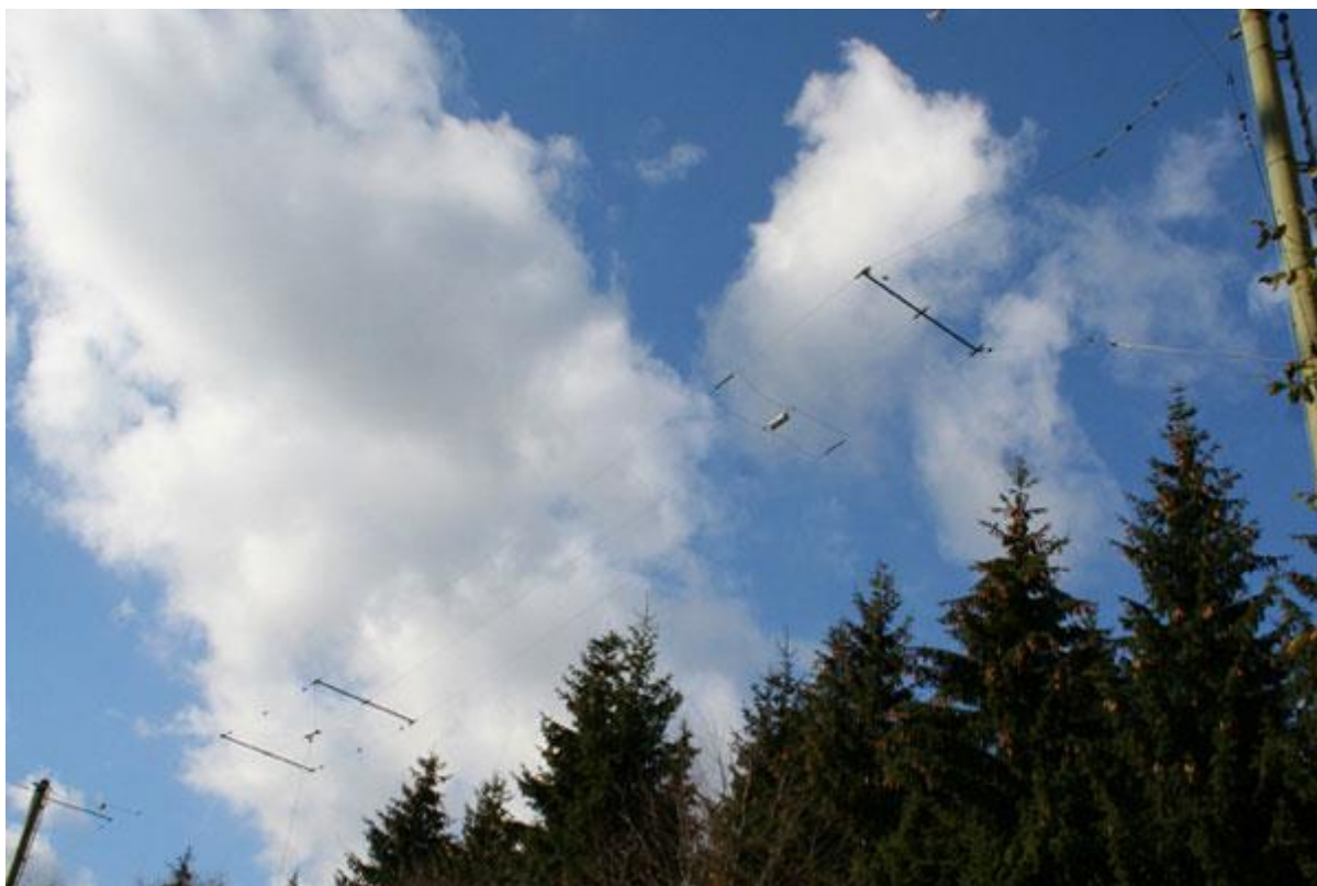
Antenne dipôle TELEFUNKEN A189 orientée Nord-Ouest – Sud Est, utilisée sur la fréquence de 6085kHz. (Photos du site « Classic Broadcast »)
