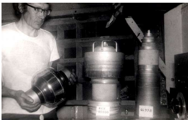
Après le rachat aux enchères du Mi Amigo, inventaire des pièces de rechange des émetteurs avant la remise en fonctionnement en 1972. Ici un tube final et un tube modulateur de rechange. Mike Bass tient en main une capacité sous vide.
