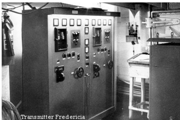
A bord du « Fredericia », les deux émetteurs 316B couplés, de 10 KW chacun.
