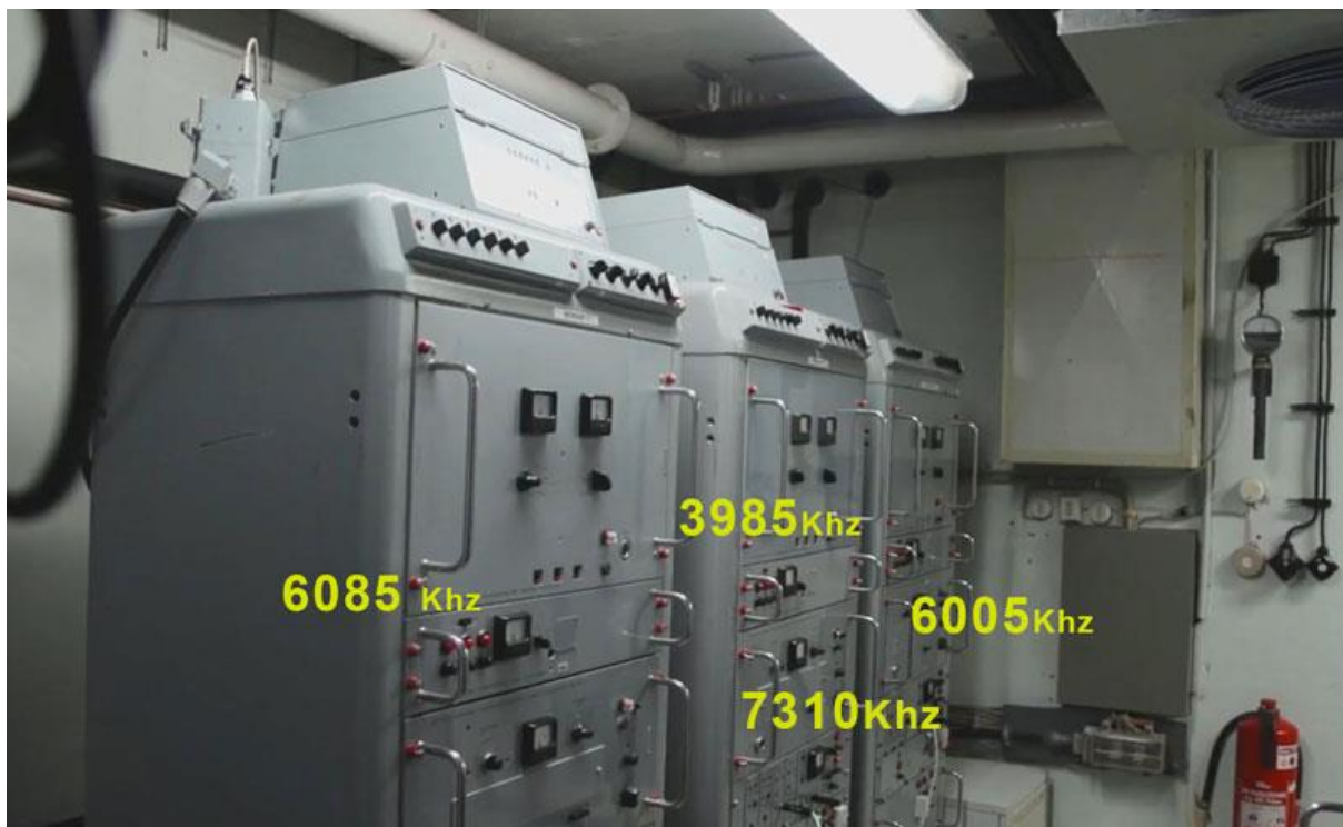
Les trois émetteurs d'1 kW et les fréquences d'émission, 3 pour Mi-AMiGO et 1 pour Radio700 (Capture de la vidéo)
