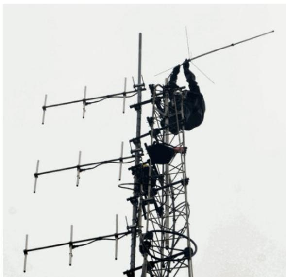
**Les lignes de montée/descente coaxiales** pour les antennes principales, se font sur du câble professionnel **Z=50 Ohms** , 7/8 pouce « **Eupen** » . Caractéristiques : **ICI**
