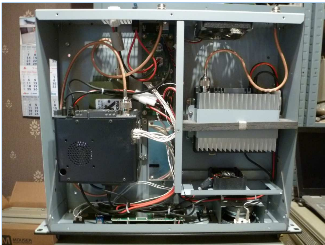
Fig. 115 : Idem figure précédente. On peut observer la position du filtre RX en dessous du bloc HF de réception. Photo : ON4IJ.
