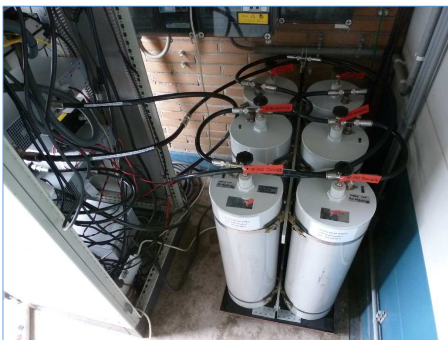
Fig. 151 : Le duplexeur est installé derrière l'armoire électronique. Les câbles de liaison, tous repérés, sont raccordés vers le rack répéteur et vers le feeder d'antenne. Photo : ON4IJ.
