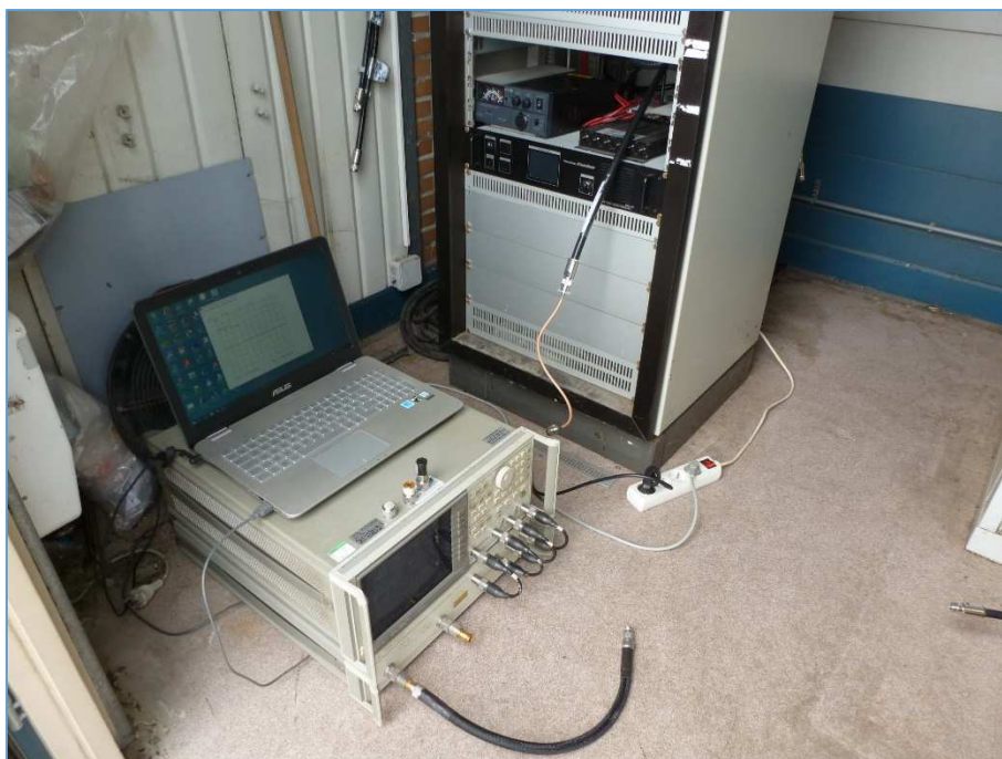
Fig. 150 : Un analyseur de réseau vectoriel est mis en batterie pour le réglage du circuit d'adaptation Z-Matcher placé à la sortie TX du rack répéteur. L'analyseur vectoriel est calibré sur le 1 er port de mesure au moyen de trois calibres ( Short, Open, Load ). La mesure du S_{11} s'effectue sur l'abaque de Smith afin de permettre un réglage précis de la partie résistive et de la partie réactive de l'impédance de l'ensemble formé par le duplexeur, les câbles de liaison, le feeder et l'antenne placée sur site. Photo : ON4IJ.
