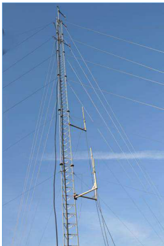
Fig. 6 : Pylône sur lequel étaient installées les anciennes antennes de ON0LG. Ici, on peut observer vers le bas de la figure deux antennes dipôles mono-bande VHF. On peut constater au sommet du pylône la présence d'antennes appartenant à un autre service de télécommunication présent sur le même site ; il s'agit d'une station de radiodiffusion FM très puissante. Source : ON5VL.org.
