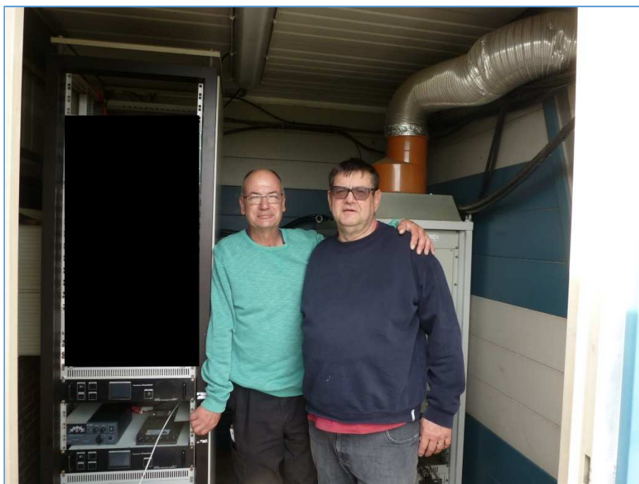
Fig. 149 : Paul ON6DP (à droite) et Jean-François ON4IJ (à gauche) à côté de l'armoire électronique lors de la remise en service du répéteur ON0LG VHF. On peut observer au premier tiers en hauteur de l'armoire électronique les deux DR1X (VHF et UHF), le duplexeur UHF et l'alimentation 13,8 V. Photo : Julian.
