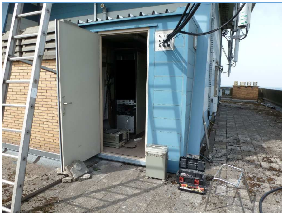
Fig. 148 : Entrée du shelter sur la toiture de la « Tour Europe » à Seraing (JO20SN) où se situent les électroniques des répéteurs ON0LG VHF et ON0LG UHF. Photo : ON4IJ.
