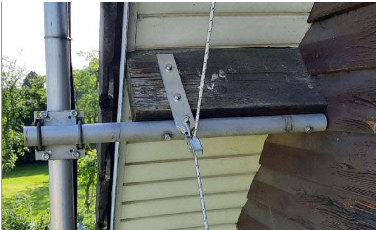
Fig. 43 : Poulie de renvoi de la drisse pour hisser le Unun de l'antenne. Photo : ON4HNO.
