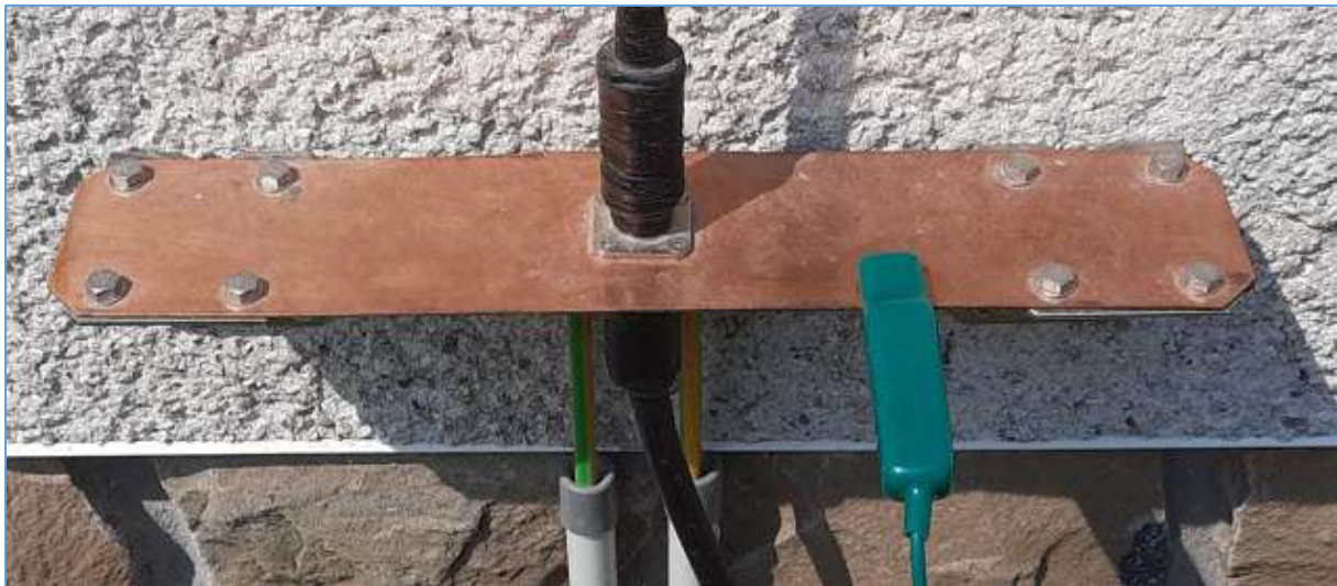
Fig. 34 : Raccordement de la prise de terre sous test au telluromètre. Remarque, le feeder d'antenne a été déconnecté de la station radio pendant les mesures et l'antenne End-Fed est complètement isolée par rapport au sol. Photo : ON4HNO.
