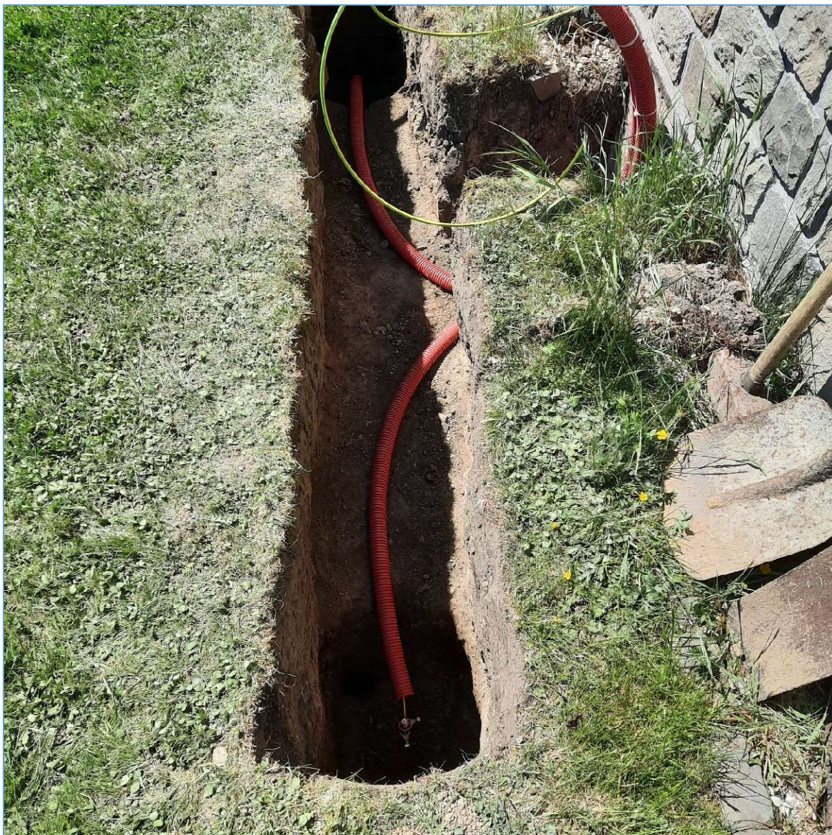
Fig. 30 : Protection du fil de terre à fond de fouille au moyen d'une gaine annelée en PVC. Photo : ON4HNO.
