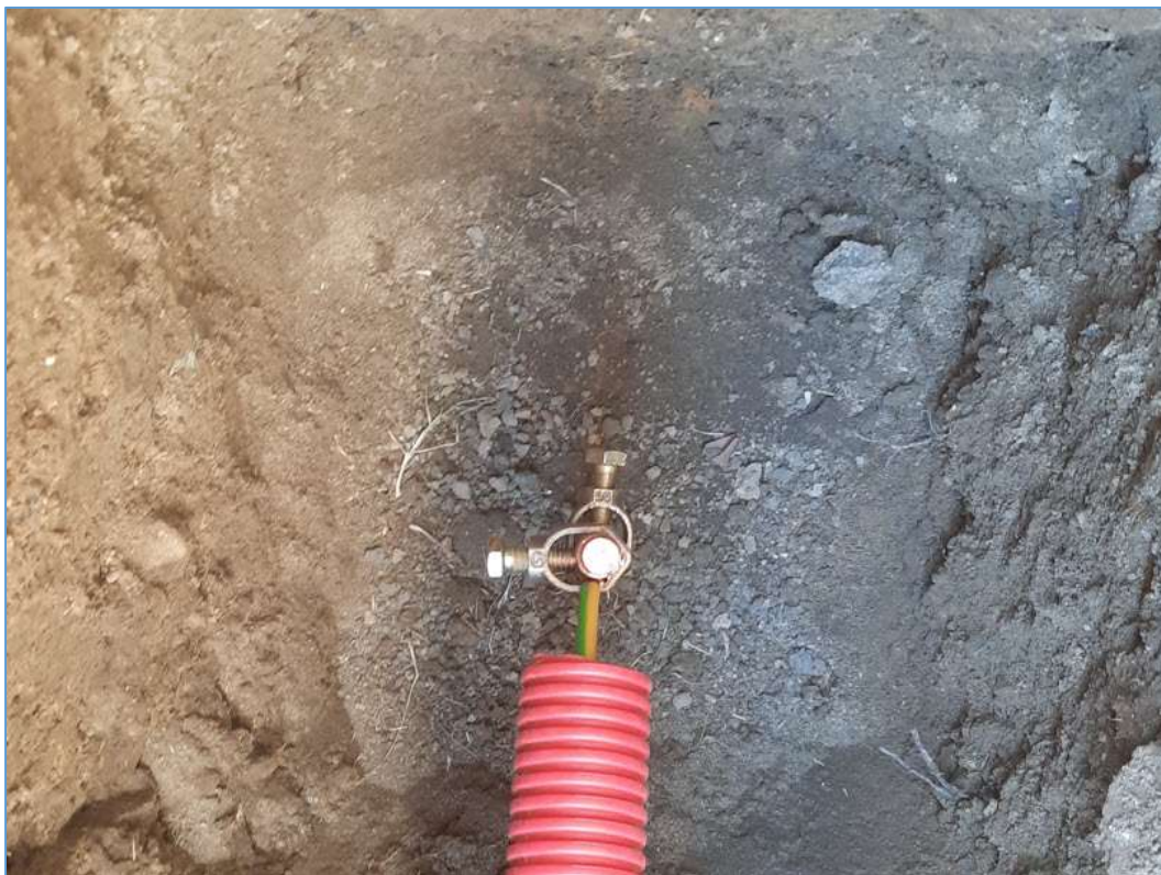
Fig. 29 : Connexion du fil au piquet de terre au moyen de deux colliers clamp en bronze. Photo : ON4HNO.
