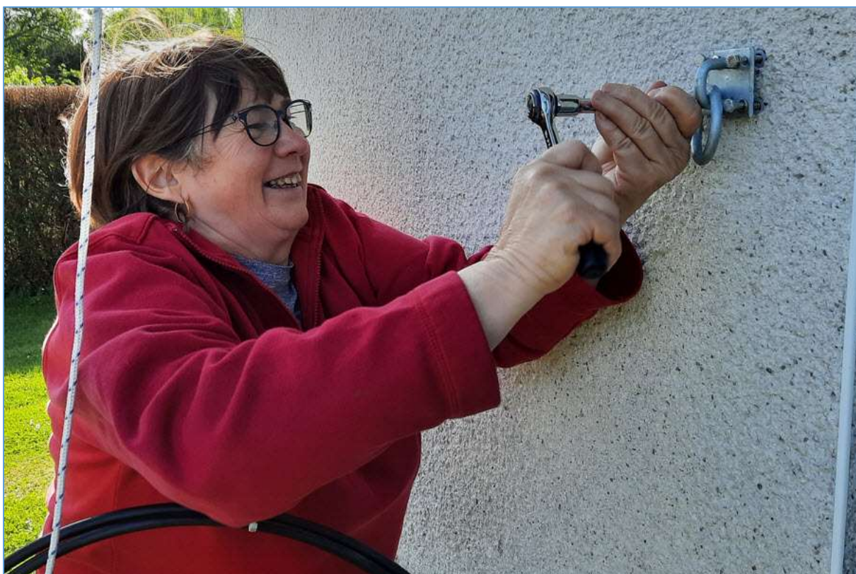
Fig. 44 : Étrier avec anneau pour l'arrimage de la drisse ON4HNO est en plein travail. Photo : ON4IJ.
