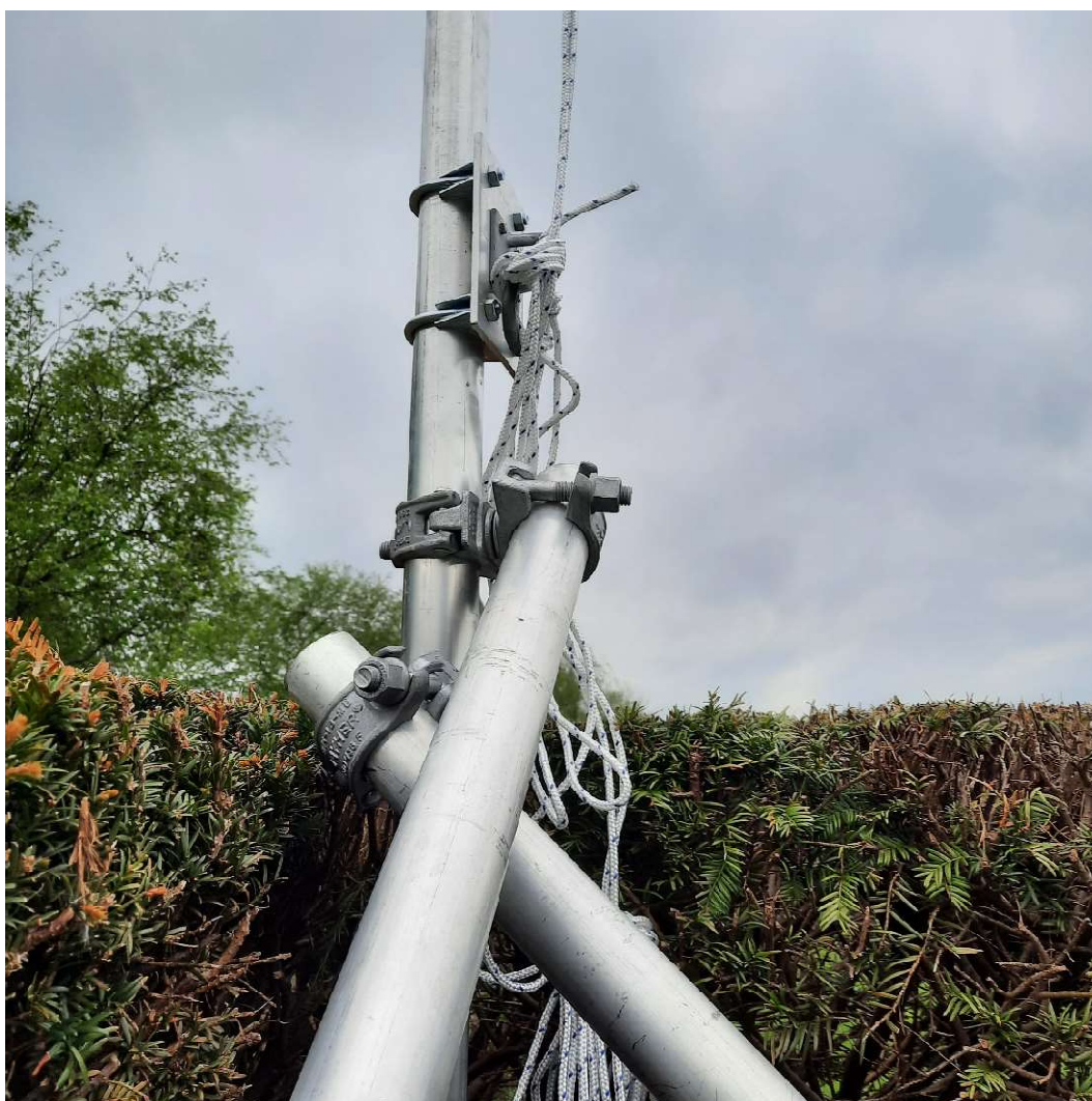
Fig. 17 : Détail de la fixation des jambes de force sur le mât au moyen de colliers « Travhydro ». Un étrier avec anneau permet d'arrimer la corde en nylon à l'extrémité de l'antenne. Photo : ON4HNO.
