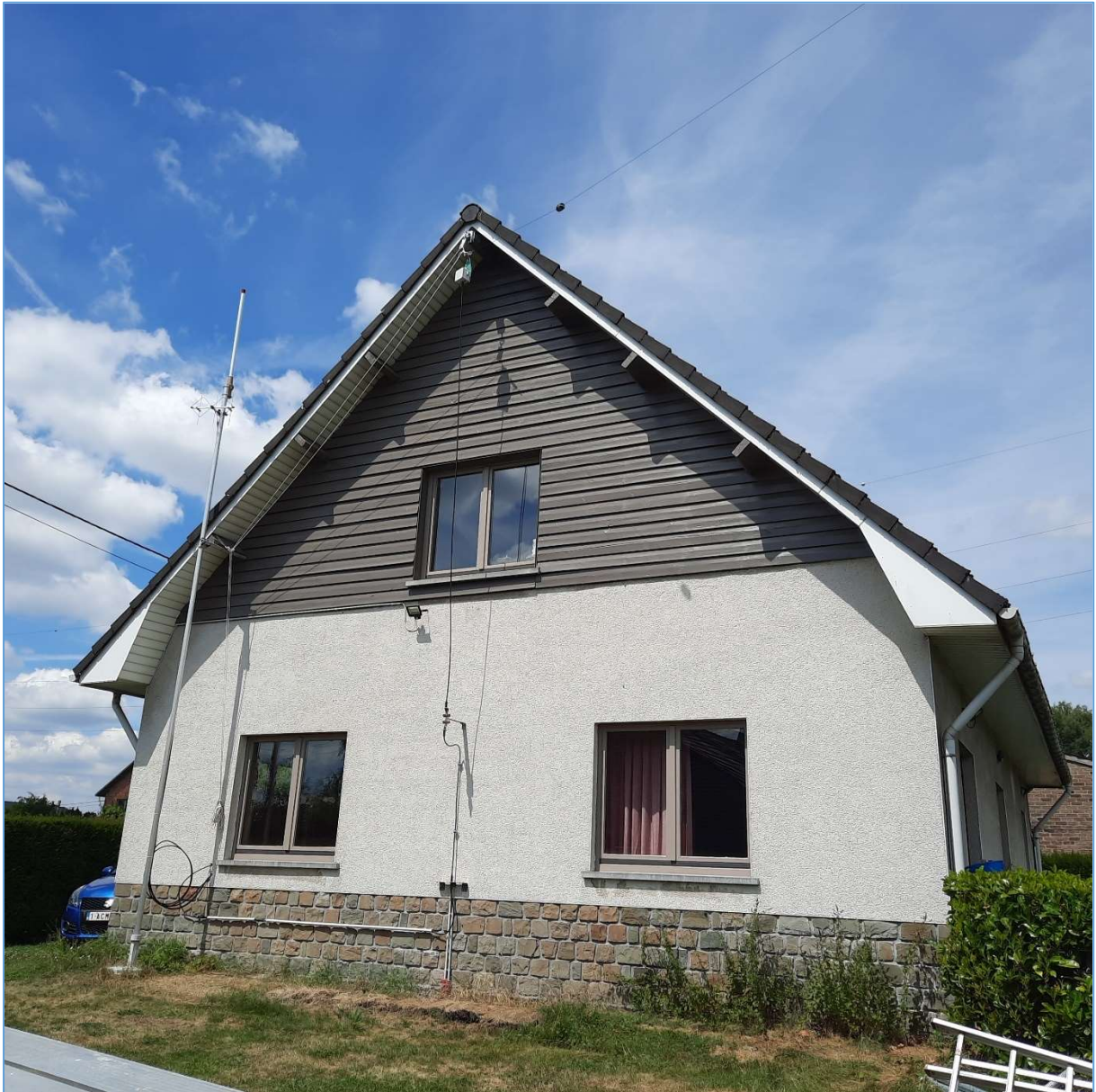
Fig. 79 : Vue d'ensemble de l'installation de l'antenne End-Fed avec le boîtier Unun, la bobine de compensation, le Common Mode Choke Unun, le feeder, le tubage, la prise de terre et le Sleeve Choke Unun. Photo : ON4HNO.
