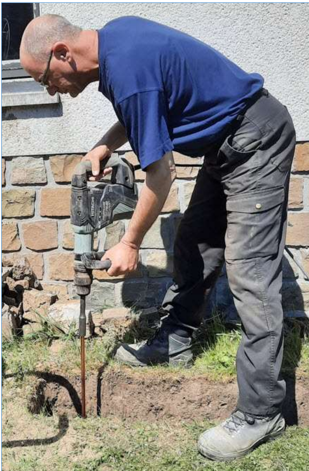
Fig. 28 : Enfoncement des piquets de terre avec une machine à percussion qui est équipée d'une bouterolle. J'ai reçu de l'aide de ON4IJ pour ce travail de force. Photo : ON4HNO.
