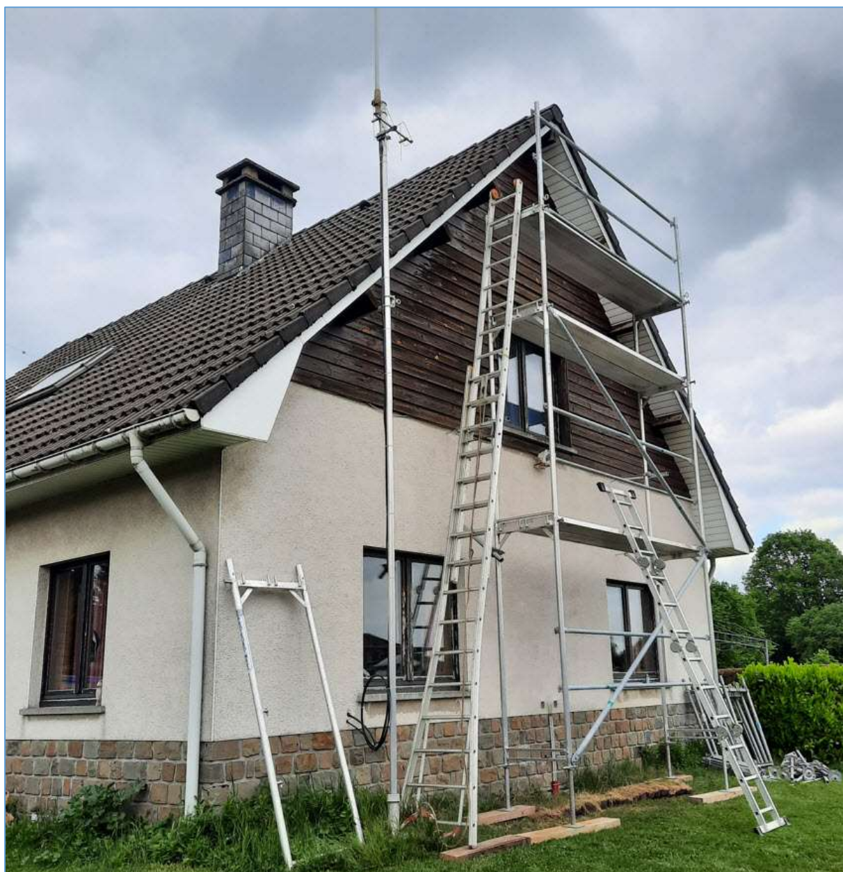
Fig. 41 : Montage d'un échafaudage pour le placement de l'ancrage de l'antenne au faîte du toit. Photo : ON4HNO.
