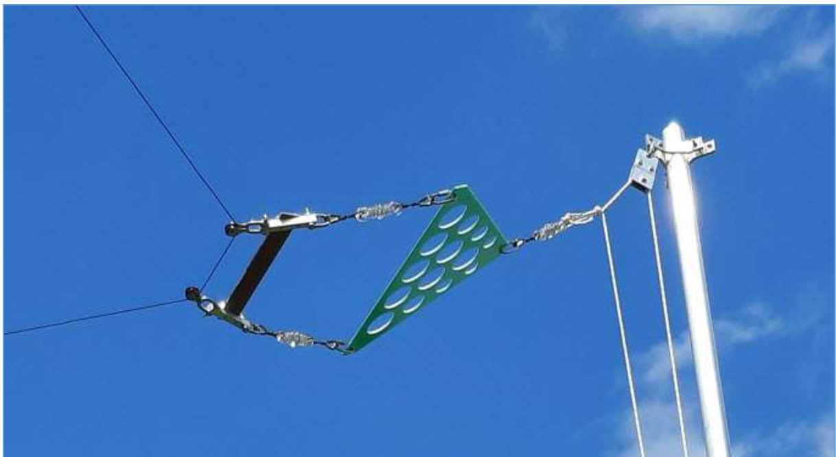
Fig. 83 : Vue de détail de l'arrimage du renvoi d'angle de l'antenne au niveau du mât arrimé à la cabane du fond du jardin. Photo : ON4HNO.
