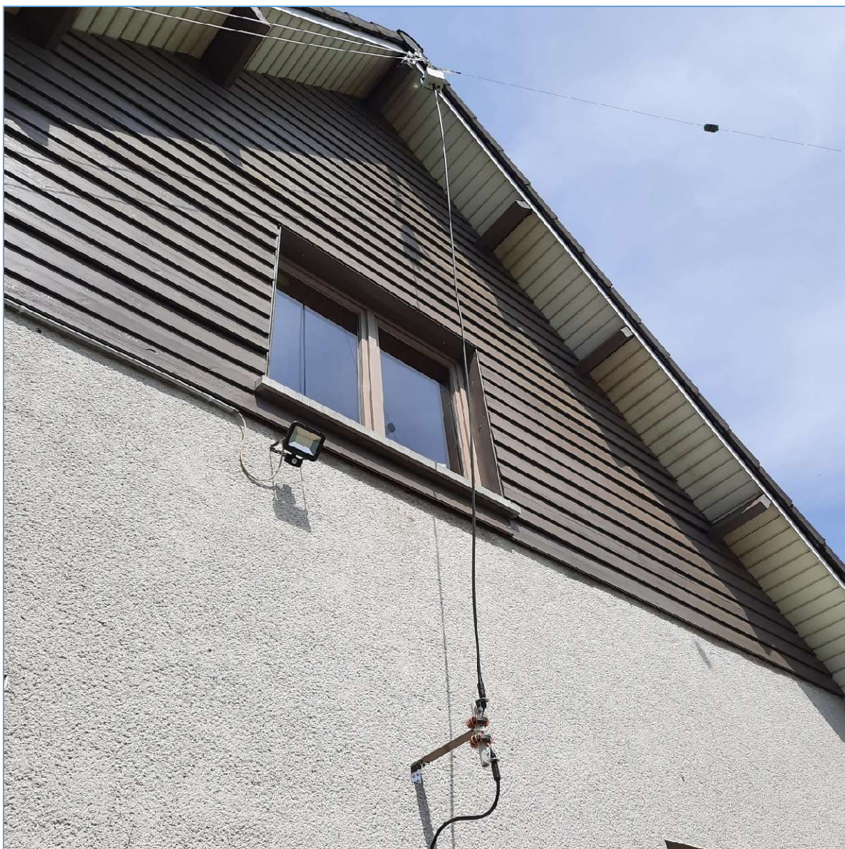
Fig. 80 : Vue de détail du Unun, du Common Mode Choke Unun, et de la partie du feeder qui sert de contrepoids de l'antenne entre le Unun et le CMC. Photo : ON4HNO.
