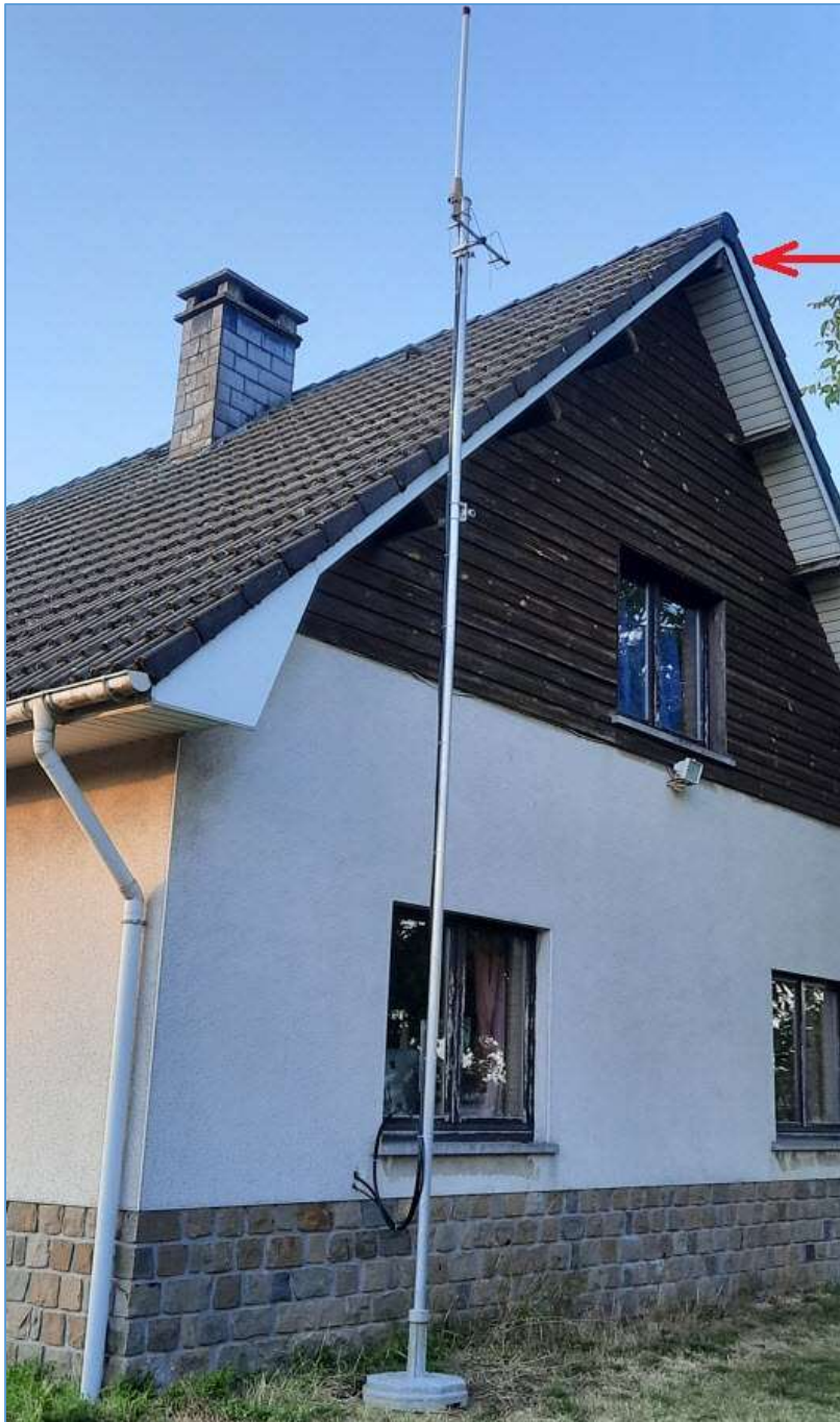
Fig. 3 : Vue du pignon de la maison où apparaît le dépassant de la panne faîtière de la toiture, là-où va démarrer l'antenne End-Fed avec un Unun. Sur le côté, il y a déjà un tube alu pour les antennes VHF et UHF. Photo : ON4HNO.
