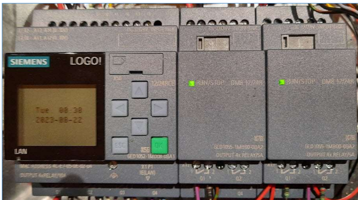
Fig. 9 : Configuration de l'unité logique Siemens en version 12 Vdc avec deux modules d'extensions de sorties numériques à relais avec contacts libres de potentiel. Photo : ON4IJ.
